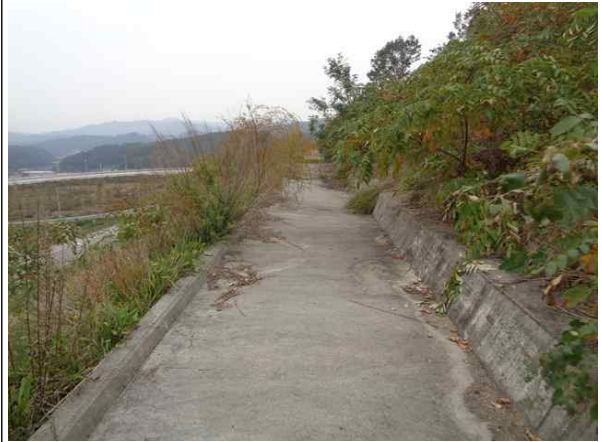
1소단 배수로 전경
