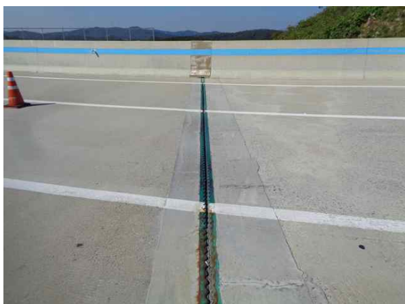
교량 상부 전경
