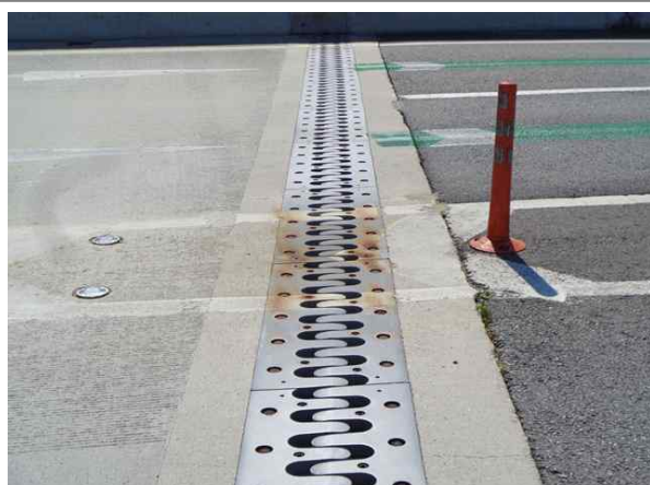
교량 상부 전경
