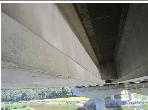
교량 거더 전경
