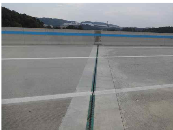
교량 상부 전경
