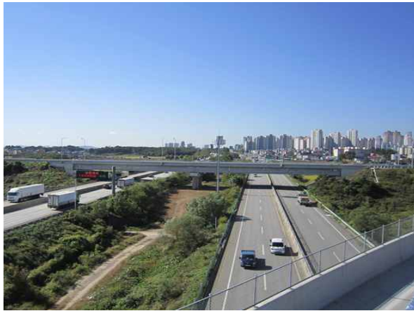
교량 측면 전경
