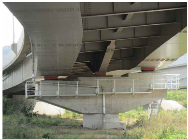
교량 거더 전경
