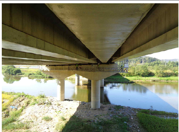
교량 하부 전경
