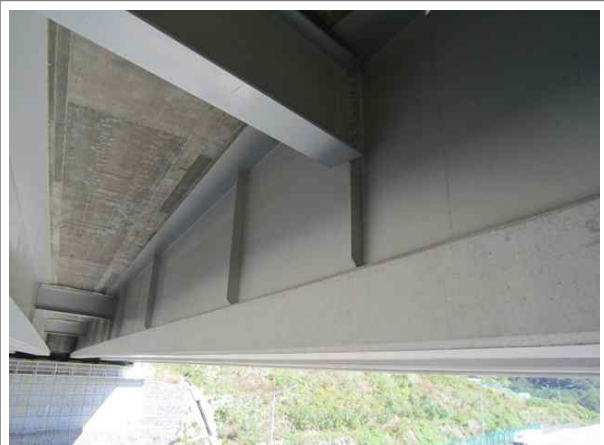
교량 거더 전경
