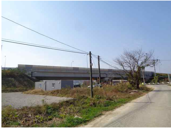
교량 측면 전경
