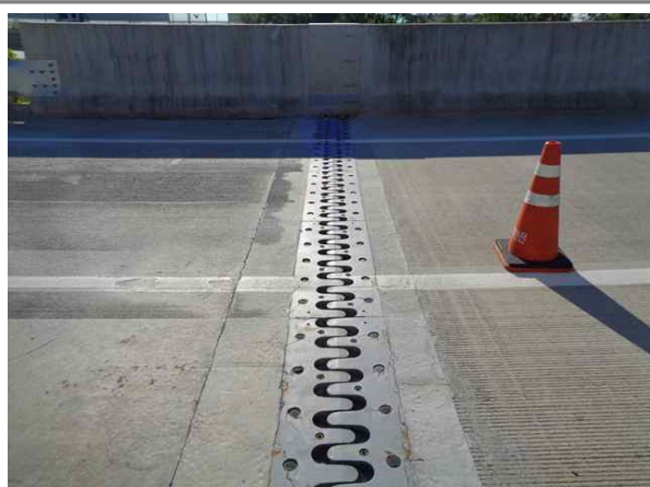
교량 상부 전경
