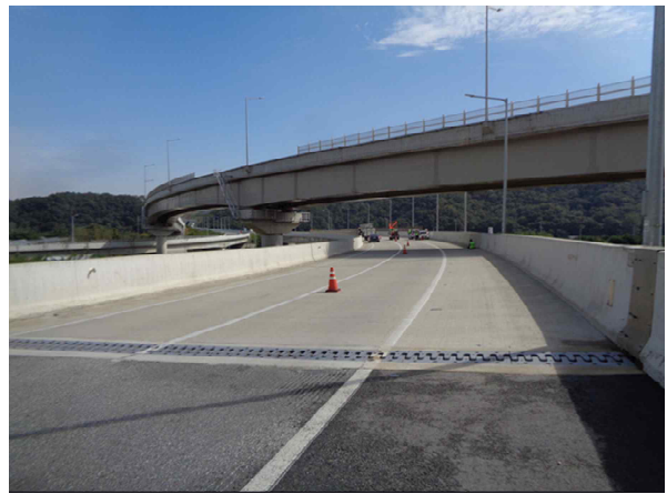
교량 상부 전경
