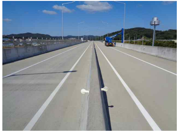
교량 상부 전경
