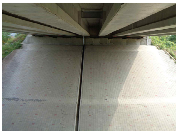
교량 하부 전경
