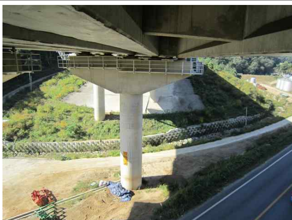
교량 하부 전경
