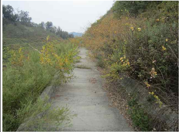
1소단 배수로 전경
