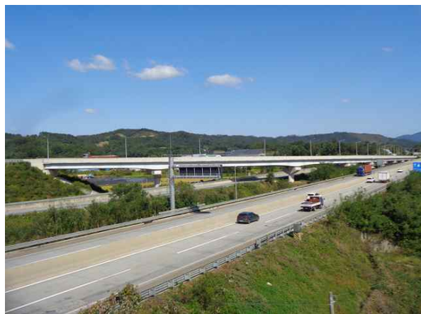
교량 측면 전경
