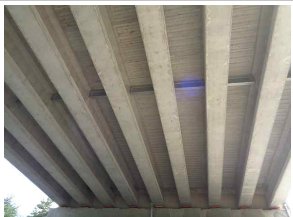
교량 거더 전경
