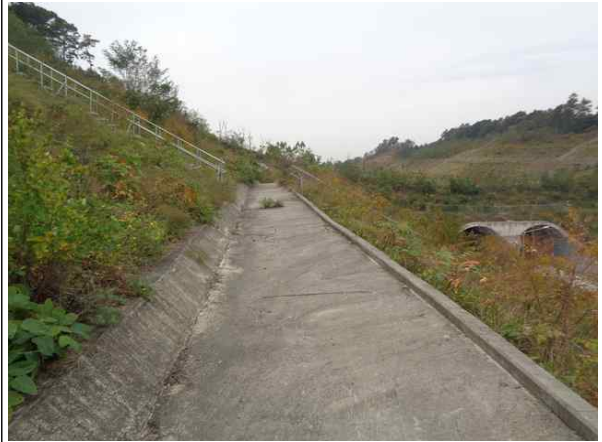
1소단 배수로 전경
