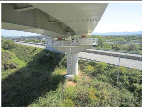
교량 하부 전경
