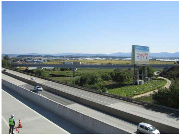
교량 측면 전경
