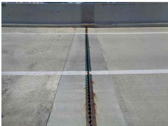
교량 상부 전경
