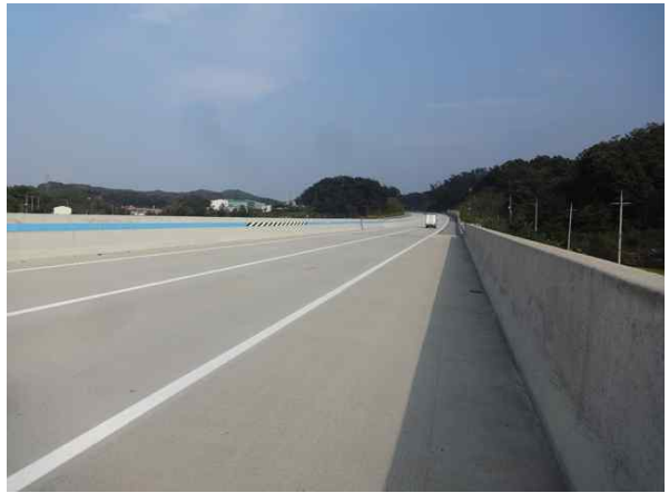
교량 상부 전경
