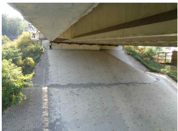
교량 하부 전경
