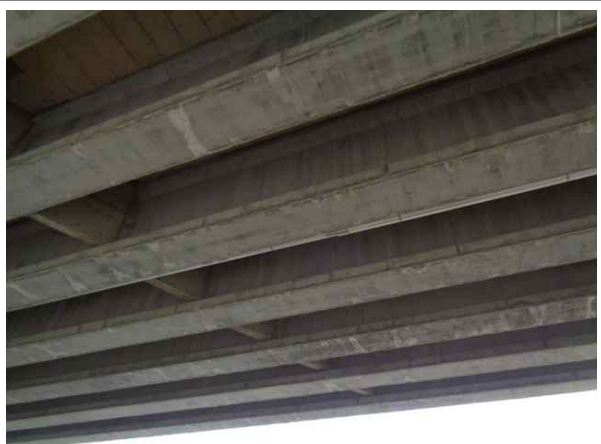
교량 거더 전경
