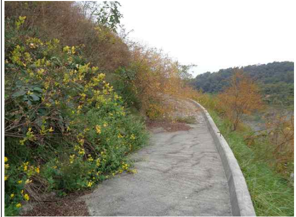
1소단 배수로 전경
