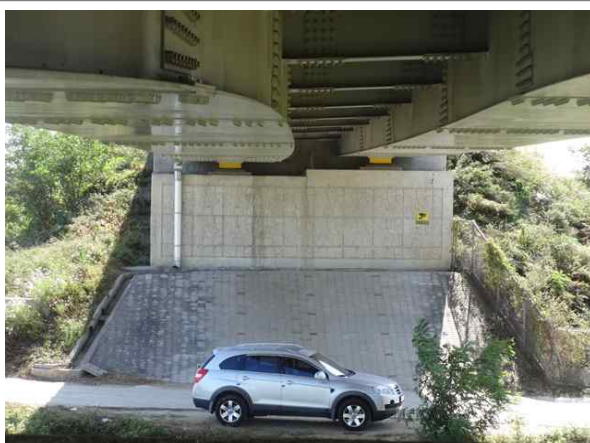
교량 하부 전경
