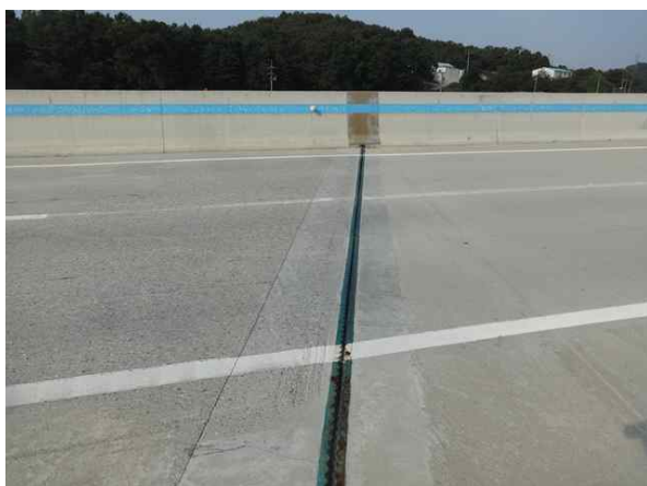
교량 상부 전경
