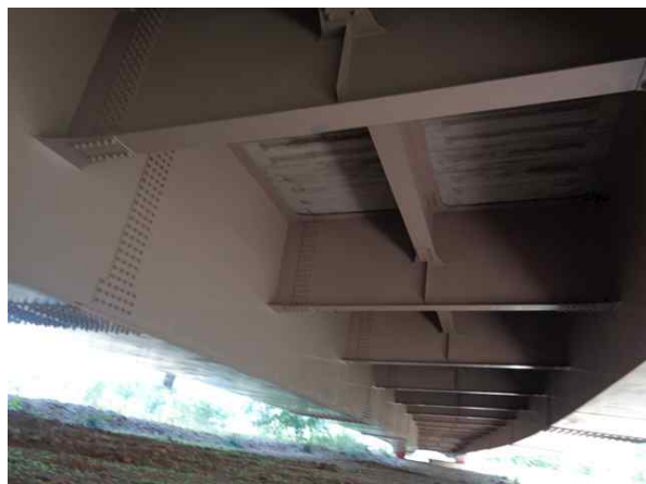
교량 바닥판 전경
