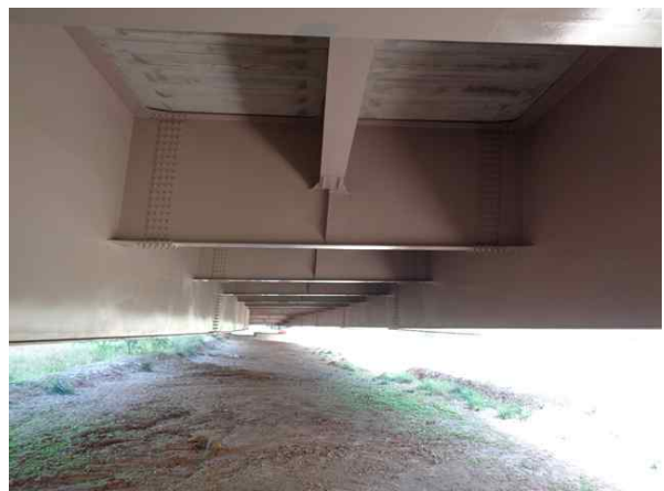
교량 거더 전경
