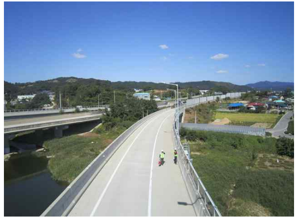
교량 상부 전경
