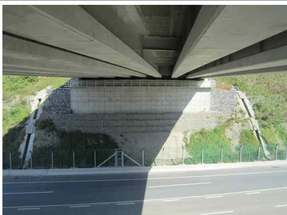
교량 하부 전경
