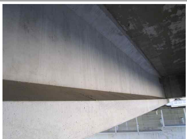
교량 거더 전경
