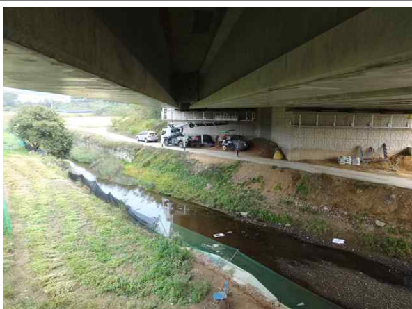
교량 하부 전경
