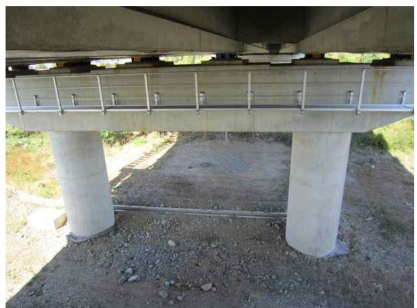
교량 하부 전경
