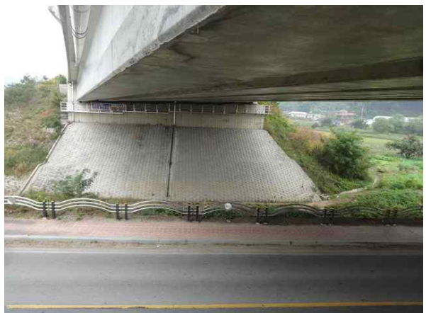
교량 하부 전경
