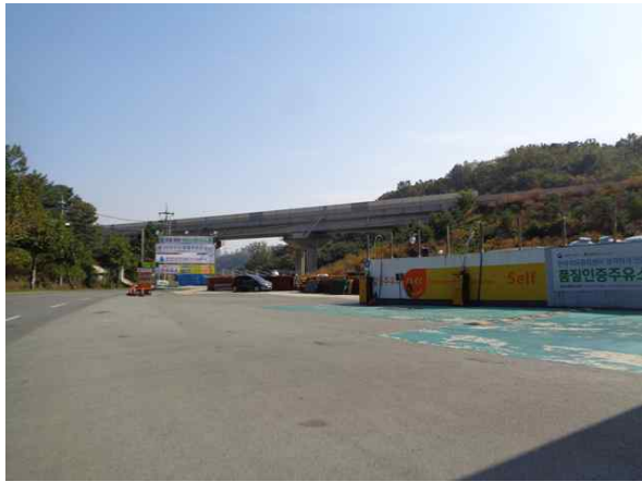
교량 측면 전경
