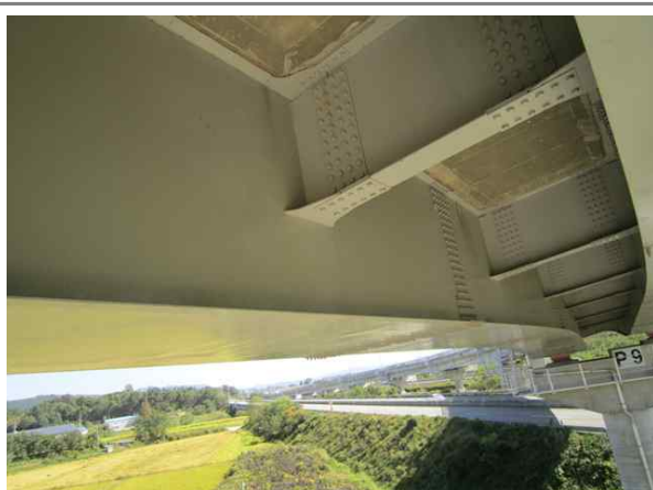
교량 거더 전경
