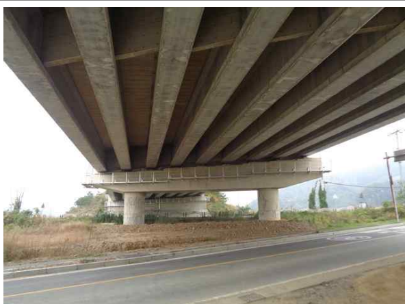
교량 하부 전경
