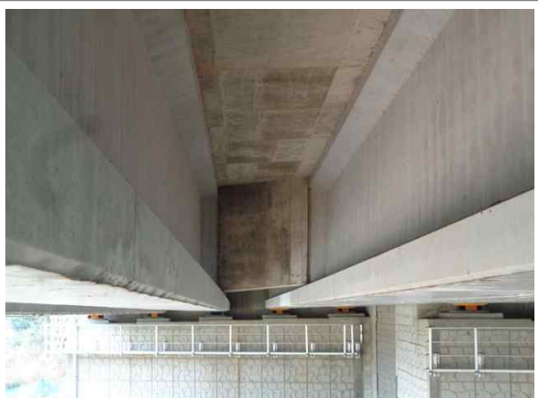
교량 거더 전경
