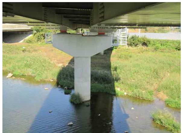
교량 하부 전경
