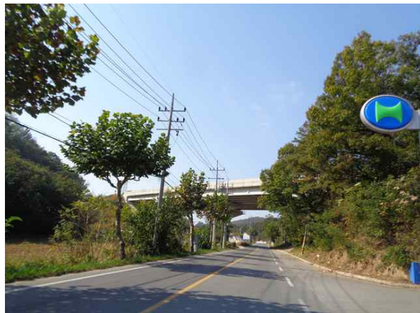
교량 측면 전경
