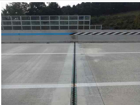
교량 상부 전경
