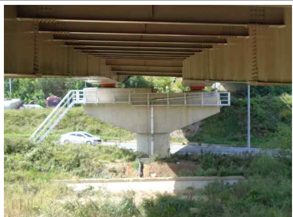
교량 하부 전경
