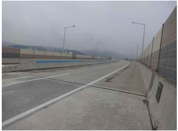
교량 상부 전경
