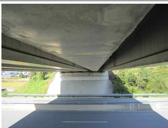
교량 하부 전경
