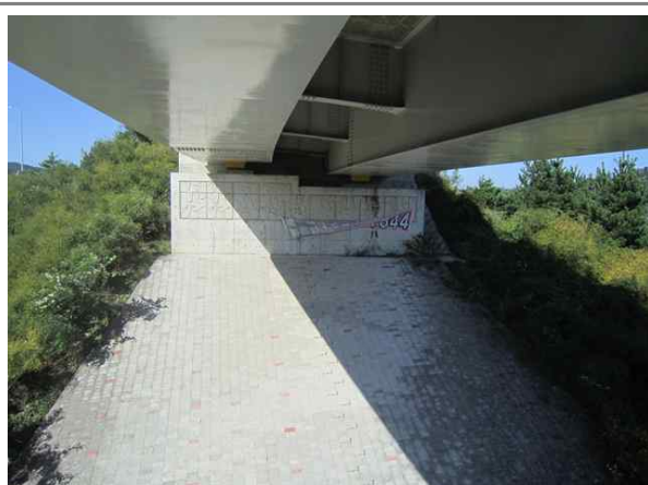
교량 하부 전경
