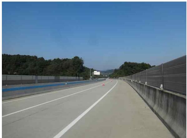
교량 상부 전경
