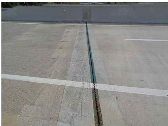
교량 상부 전경
