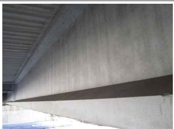
교량 거더 전경
