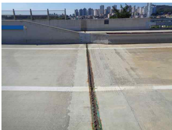
교량 상부 전경
